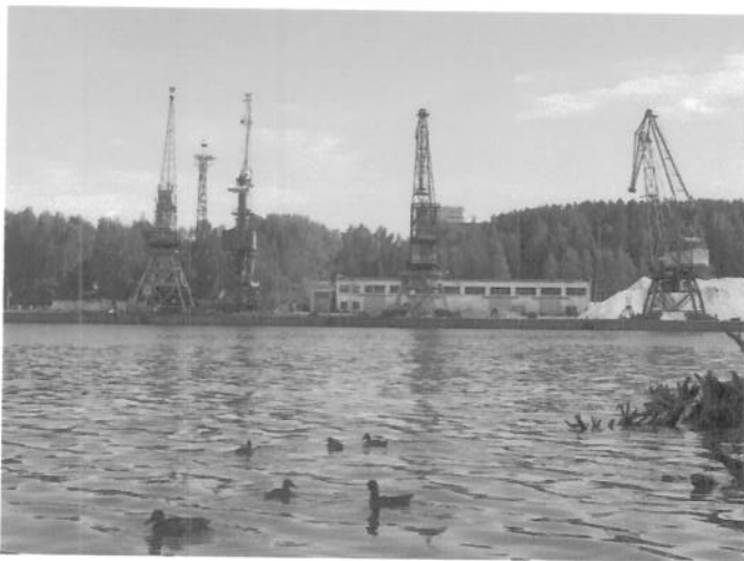
Приложение 10. Вторая рабочая площадка располагалась на песчано-глиняном берегу рэбовского леса, в 300 м северо-западного направления от речного порта, предназначенного для судоходства; подмывная рипаль, г. Чайковский, 3–6 августа 2019 года, автор фото: Дерюшева Татьяна
